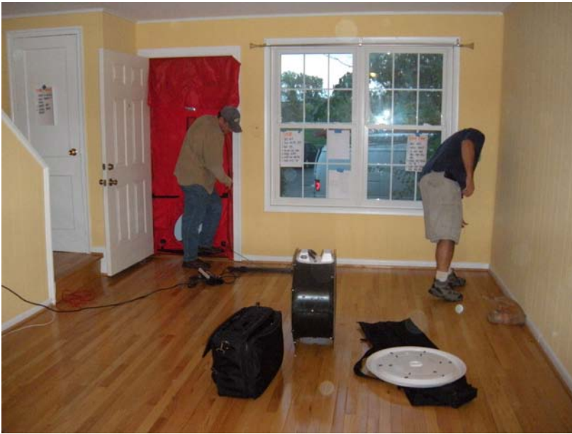
Blower door test, pre rehab
